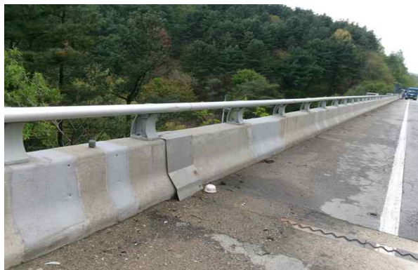
방호벽, 난간 전경
